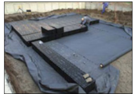
Industriegebäude, Warnsveld (NL)
